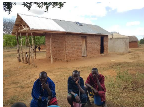
Wateropvang via dakgoot en zonnepaneel op dak
